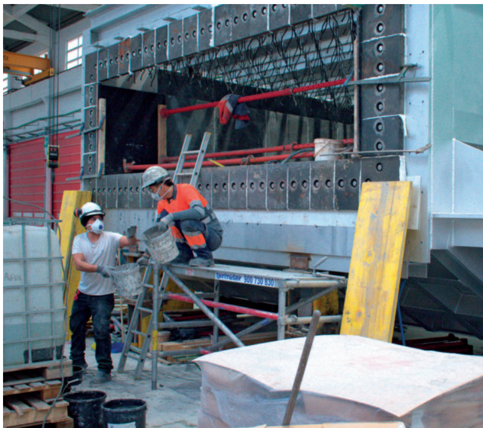
La industria y los servicios conexos concentran casi dos terceras partes de la actividad. (Montaje de un horno en GHI).
